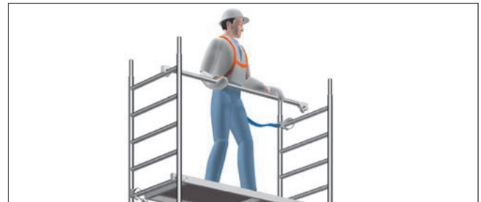
Bild 3: Sichere Montage der Rückenlehnen mit PSA
