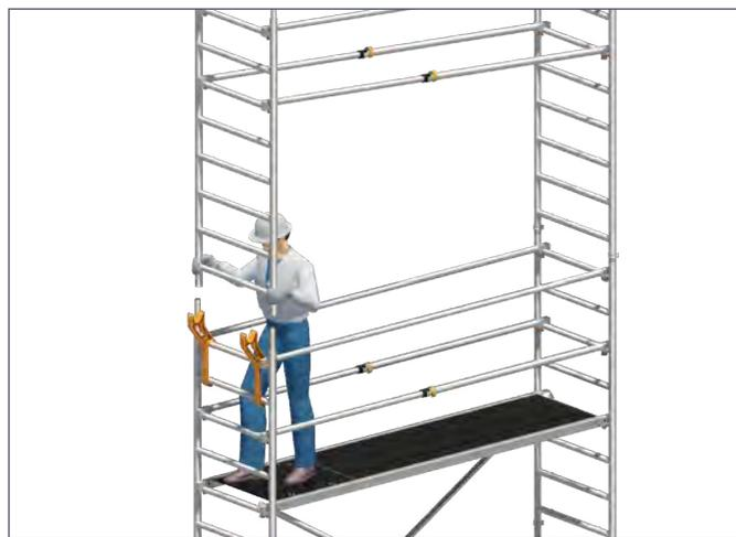
5. Standleiter 75/8 **15** auf der Seite der Uni Montagehaken ausheben, mitsamt des noch montierten Seitenschutzes nach unten schwenken und in den Montagehaken **27** positionieren.
