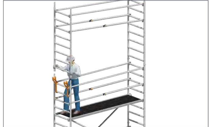
3. Die zweite Standleiter 75/8 **15** mitsamt dem vormontierten Seitenschutz nach oben schwenken, aufstecken und mit Federsteckern **16** sichern.
