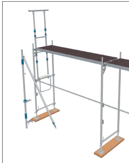
Bild 31: Montage des ersten Geländers am Montagepfosten
