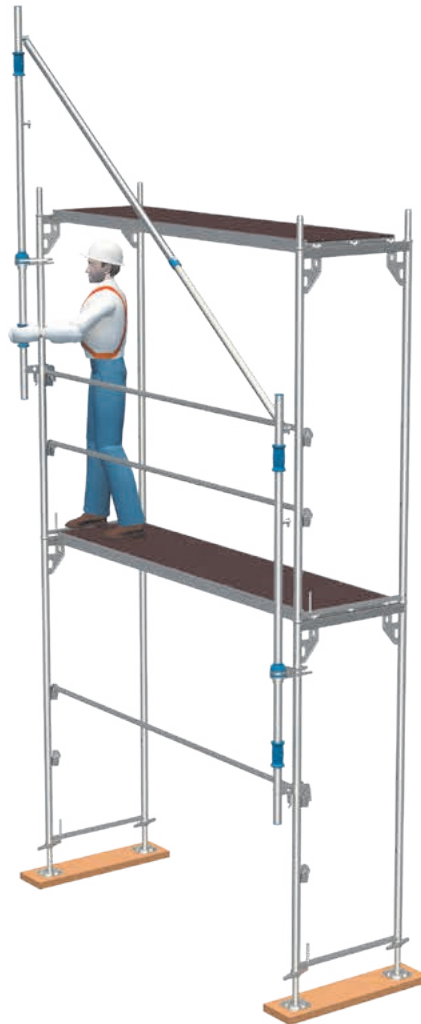
Bild 28: Umsetzen eines ersten Montagepfostens in die nächst höhere Lage
