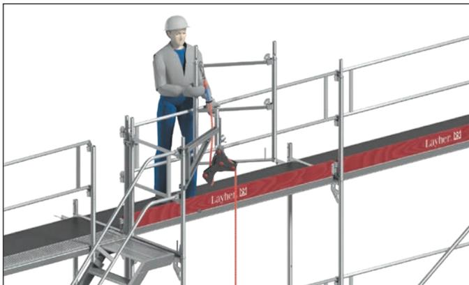
Die Konsole zum Gerüst schwenken und das Gerüstmaterial vom Haken nehmen.
