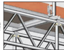
Aufgesetzt auf systemfreie Gitterträger bei Überbrückungen kann mit Stellrahmen 0,73 m breit auch im Systemraster weitergebaut werden.
