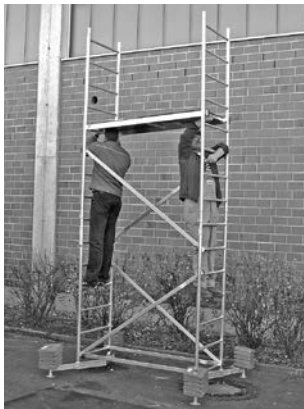
Grundgerüst mit erster und zweiter Aufstockung
