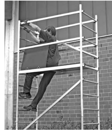
Grundgerüst mit erster Aufstockung
