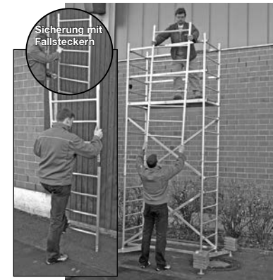
Grundgerüst mit erster und zweiter Aufstockung
