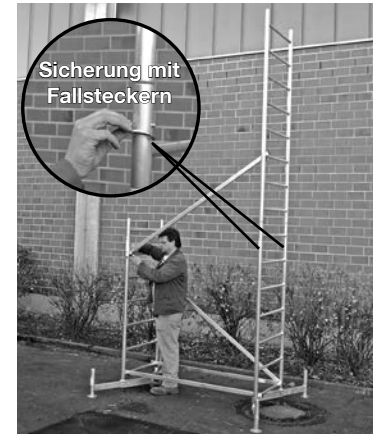
Grundgerüst mit erster Aufstockung
