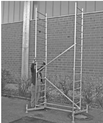
Grundgerüst mit erster Aufstockung
