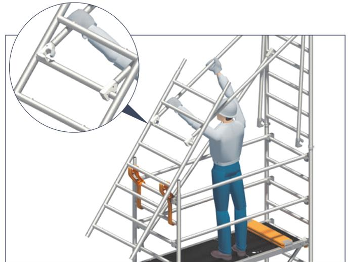
13. Mit Hilfe des Stirnbretts oder einem zusätzlich zur Verfügung stehenden Geländer, welches jeweils als Verlängerung dient, wird der Schließbügel der Einrastklauen von einem der noch montierten Zwischengeländer bzw. Geländer **20** in ca. 2,5m Höhe gelöst und die Einrastklaue damit einseitig ausgehoben. Im Anschluss kann das einseitig gelöste Geländer **20** nun auf der in den Uni Montagehaken **32** positionierten Seite gelöst und durch eine Drehung in eigener Achse um 90° demontiert werden.
