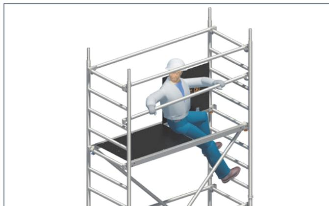
5. Innenseitiger Aufstieg über die Sprossen der Standleiter durch die dafür vorgesehene Durchstiegsklappe. In der Durchstiegsöffnung sitzend, absturzesichert durch die Holme der Durchstiegsbrücke **31**, erfolgt die Montage des Zwischengeländers der nächsten Lage. Hierzu werden die Geländer **20** an den zweiten Sprossen über der Standfläche montiert.
